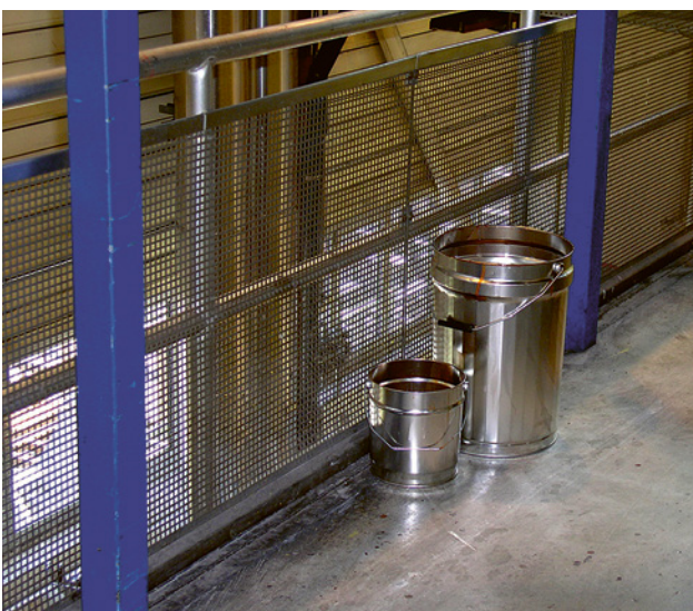
17 Das zusätzlich angebrachte, vollflächige Gitter verhindert wirksam den Absturz von Gegenständen oder Personen.
