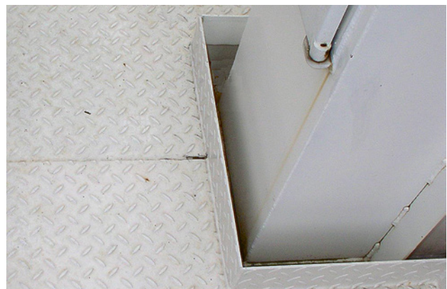
9 Fussleiste um eine Bodenöffnung, deren horizontaler Abstand zur Säule mehr als 20 mm beträgt.
