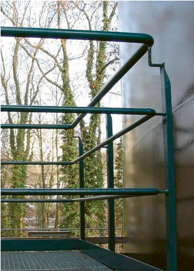
14 Podestgeländer mit einem abgesetzten Handlauf. Der Freiraum zwischen Handlauf und angrenzender Wandung beträgt mindestens 75 mm.
