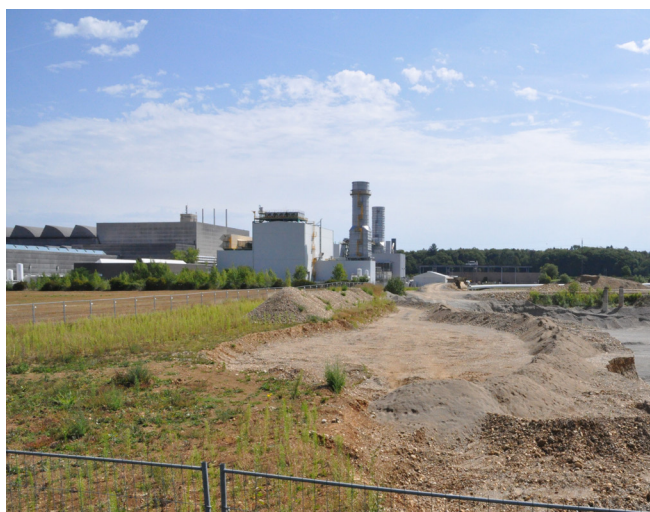
Abbildung 6: Grundstück heute - Im Vordergrund der Kiesabbau, der durch Kibag AG betrieben wird
