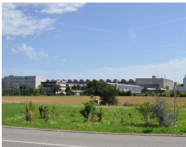
Abbildung 5: Grundstück heute - Eigenämterstrasse, im Hindergrund General Electric-Anlage
