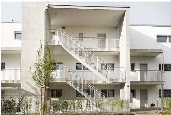
Abbildung 5 Gerade Treppe als interne Gebäudeerschliessung beim Laubengang
